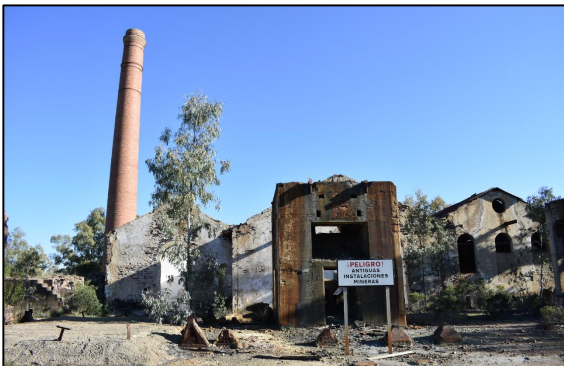
Chimenea de la antigua caldera de vapor.
