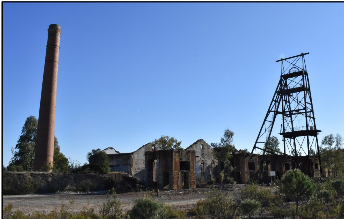
Vista de las infraestructuras mineras de extracción y almacenamiento del mineral explotado.
