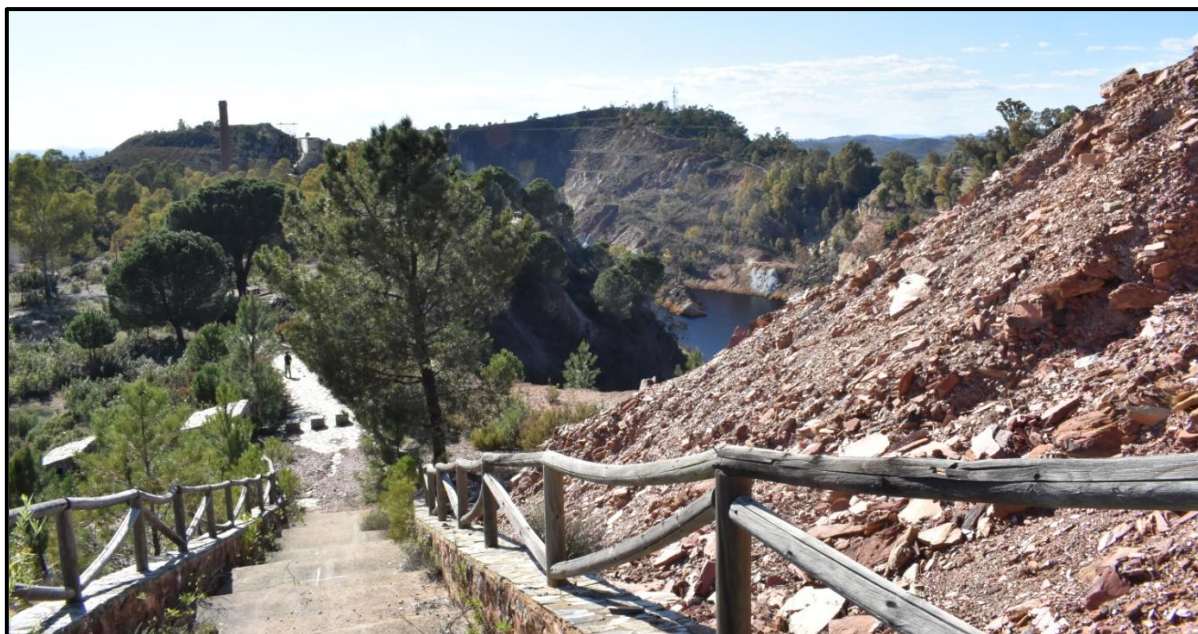
Escaleras hormigonadas y escombreras aisladas por medio de vallado.
