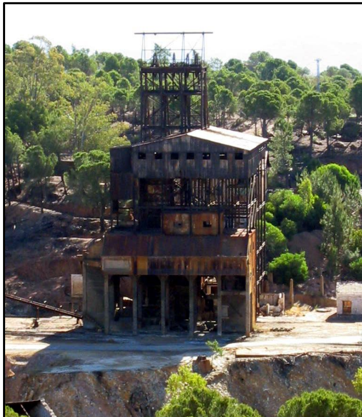
Vista frontal del castillete del pozo de la Algaida o n.º 5.
