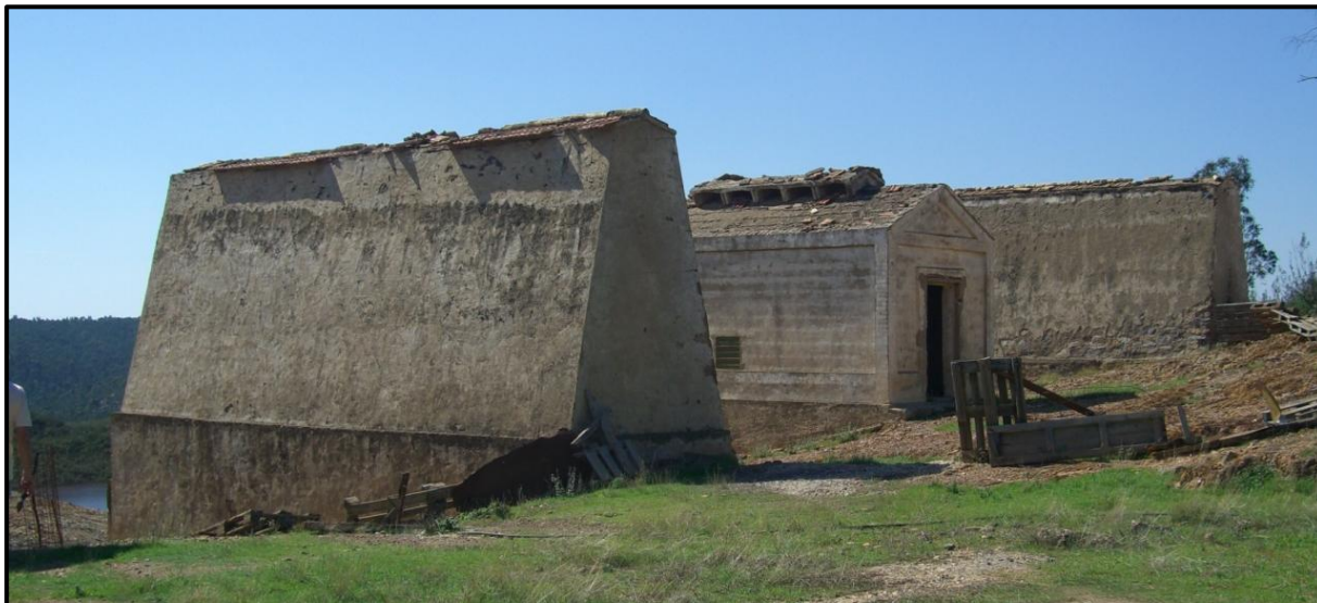
Vista delantera de los polvorines y sus protecciones.
