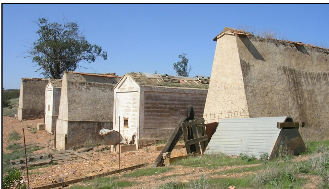
Vista trasera de dos polvorines y sus protecciones.
