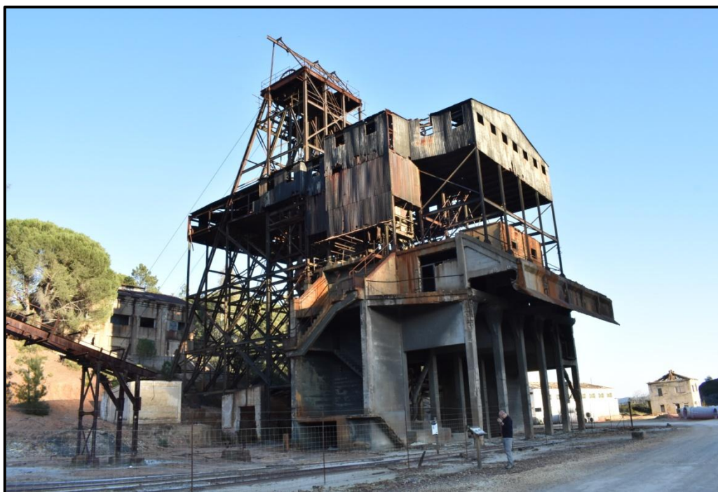
Vista lateral del castillete del pozo de la Algaida o n.º 5.
