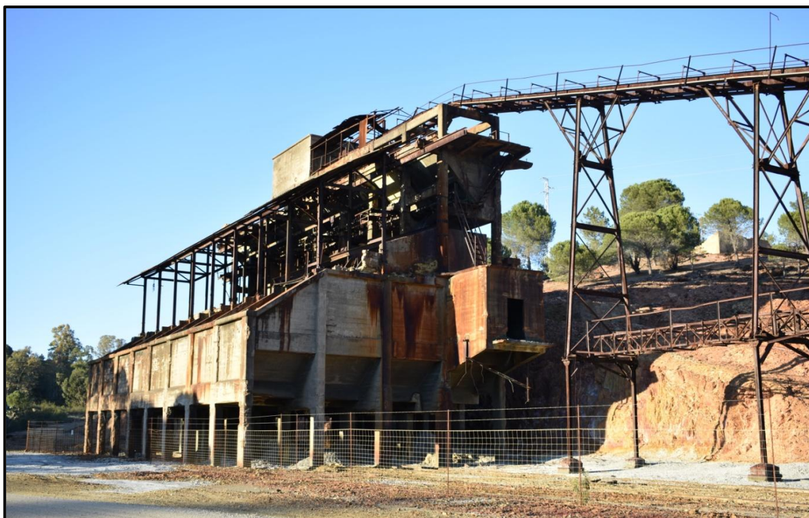
Instalaciones de trituración, clasificación y carga del mineral adosadas del pozo de la Algaída o n.º 5.
