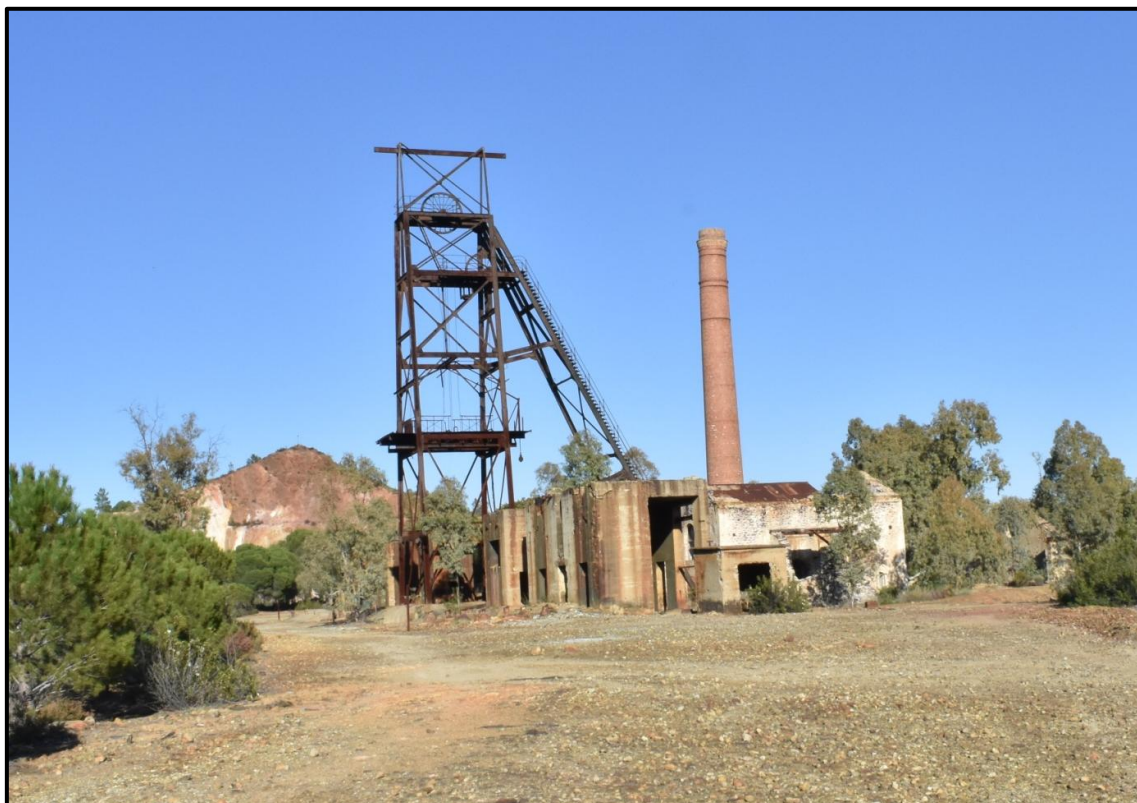
Castillete del pozo n.º 4 y otras instalaciones mineras.
