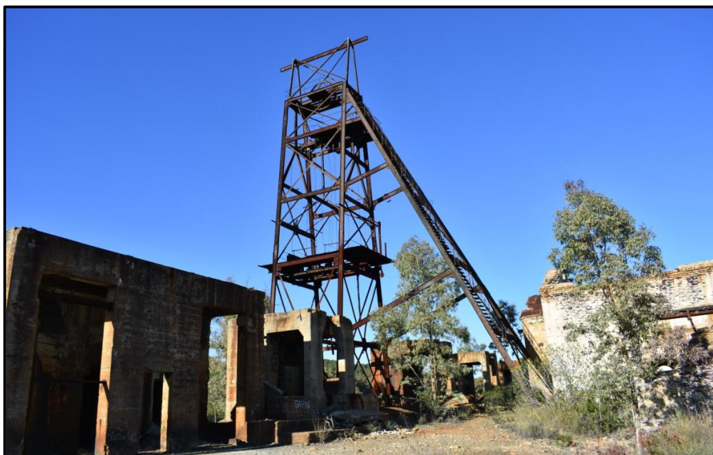
Castillete del pozo n.º 4.
