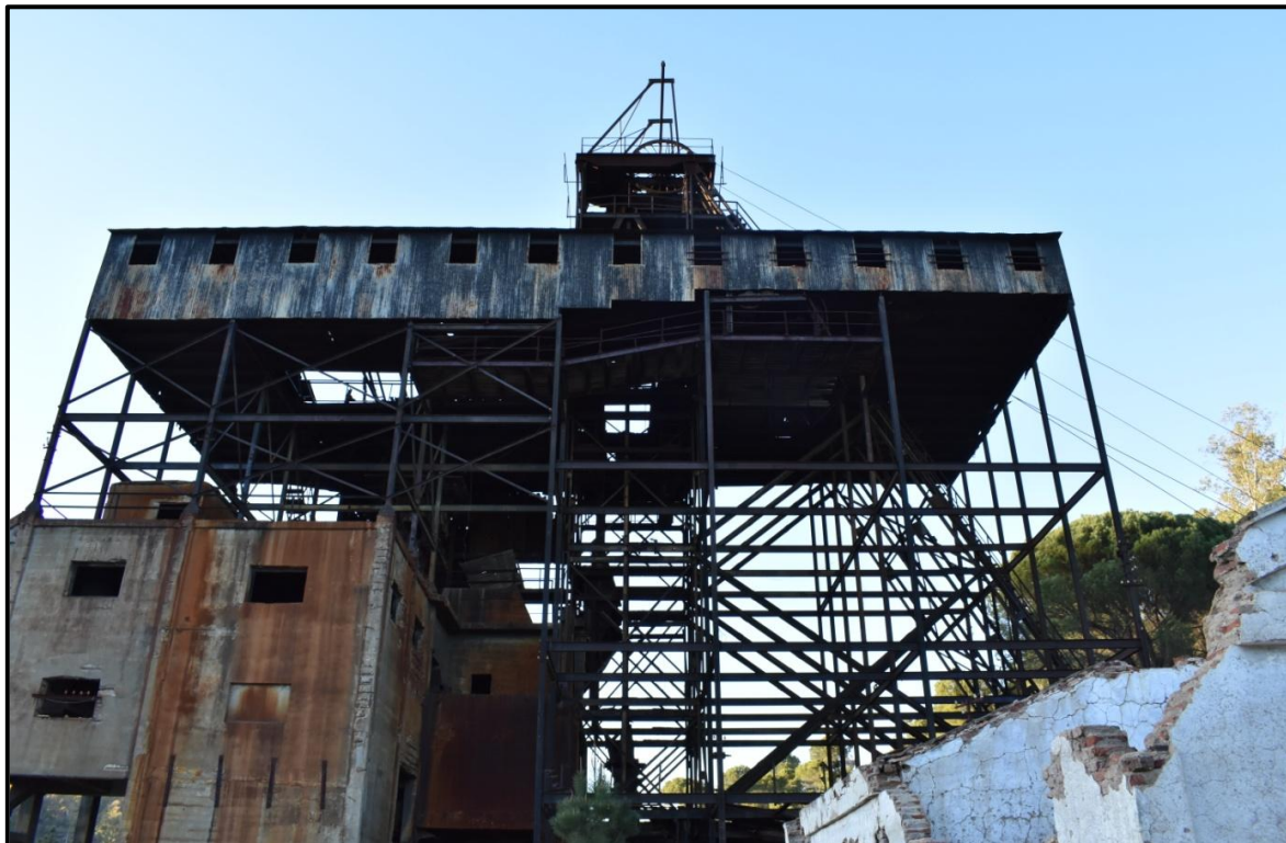
Detalle del castillete del pozo de la Algaída o n.º 5.
